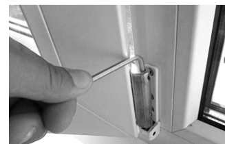
Рис. 7. Регулировка положения створки по вертикали
