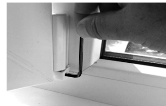
Рис. 8. Регулировка нижней петли – изменение положения створки по горизонтали
