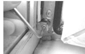
Рис. 9. Регулировка нижней петли при открытой створке.
