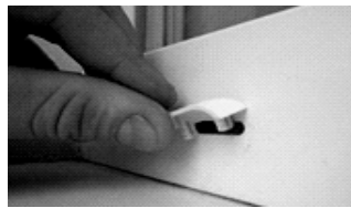
Защитный колпачок с наружной стороны рамы
