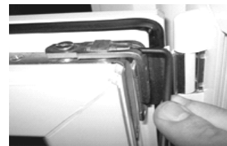
Рис. 10. Регулировка верхней петли – изменение положения створки по горизонтали
